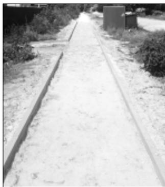
В р. п. Самойловке продолжается реализация программы по строительству и ремонту тротуаров, инициированной губернатором области Романом Бусаргиным. На ул. Пушкина идут работы по установке бордюрного камня и подсыпке щебня. Тротуар будет построен до ул. Пролетарской, что обеспечит более комфортный и безопасный подход к районной больнице и другим объектам социальной сферы.
