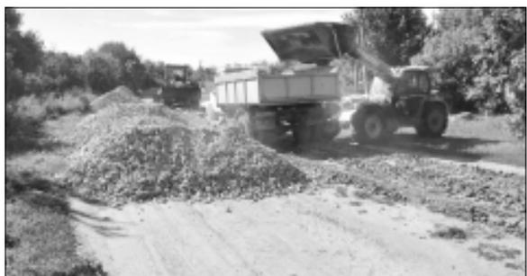
Главы крестьянско-фермерских хозяйств, работающие в с. Песчанке, проводят ремонт участка дороги на ул. Березовка. Уже проведено киркование, уложена водопропускная труба. Запланированы работы по грейдированию и подсыпке щебнем.
